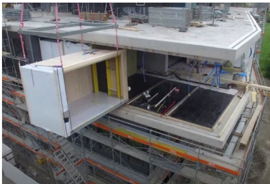
Монтаж готового модуля до бетонного каркасу. Джерело: компанія "EMPA"
