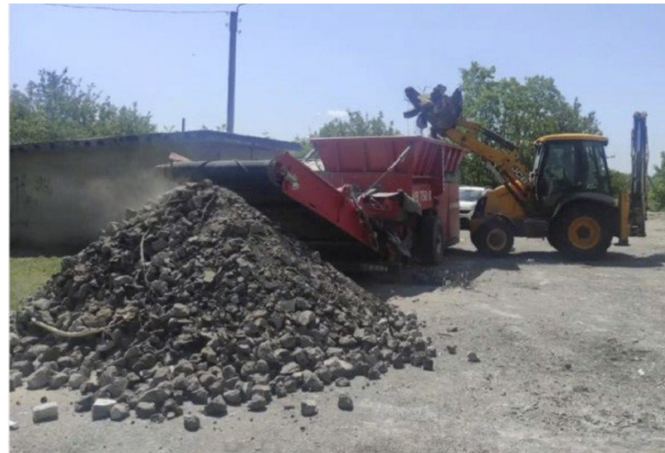
Робота подрібнювача бетону в м. Харків. Джерело: фейсбук-сторінка компанії "Олнова"
