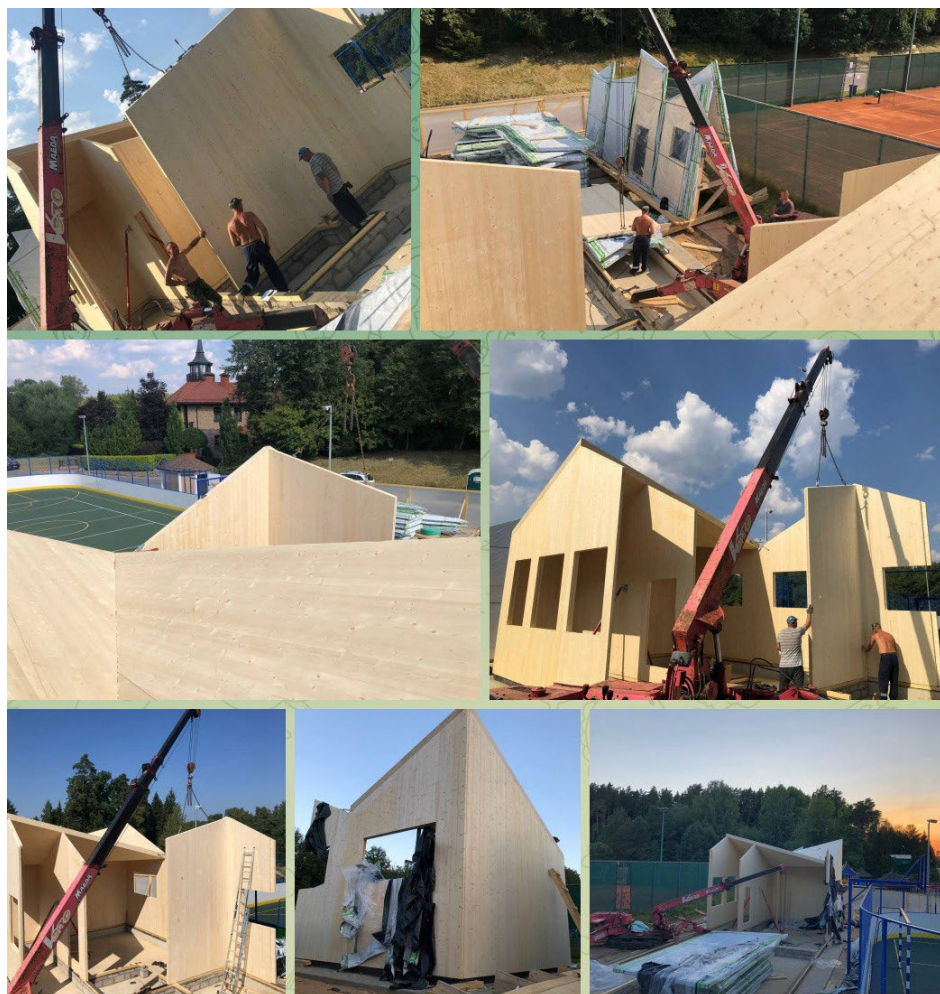
Джерело: приватна практика Андрія Бідакова, інженера, експерта з деревинних конструкцій
