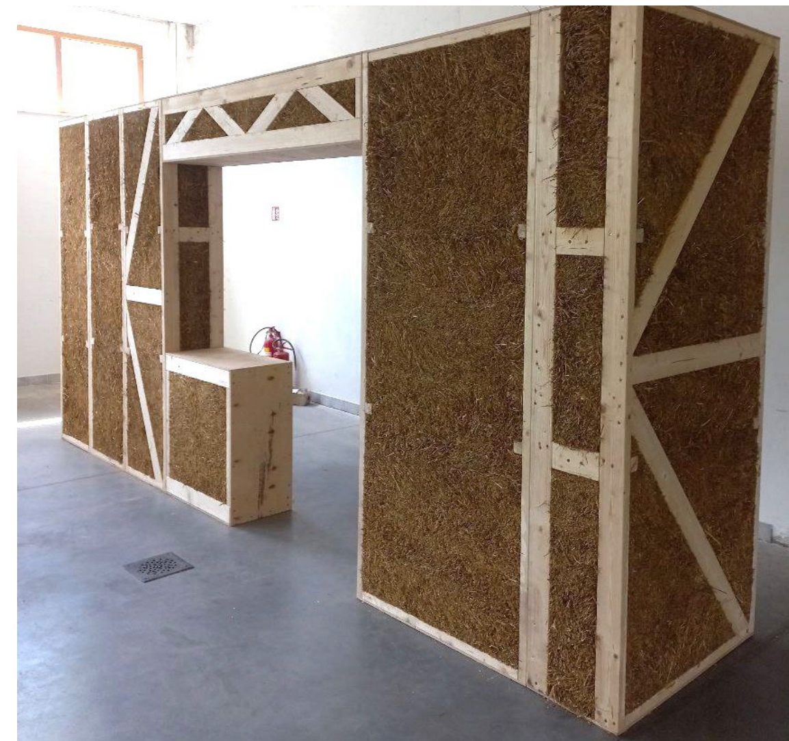
Панелі та будинки виробництва компанії "Life House Building" Джерело: https://www.instagram.com/life.house.building
