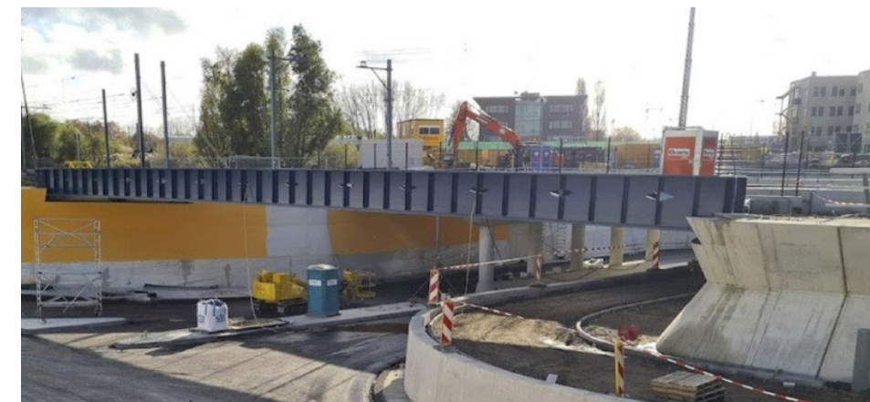
Тут циркулярна бетонна суміш виробництва компанії "Рутте Груп" (Rutte Group) за технологією Смарт Крашер (SmartCrusher) використовується як складова залізобетону, який відділяє велосипедну доріжку від автомагістралі. Джерело: slimbreker.nl , 2022 р.
